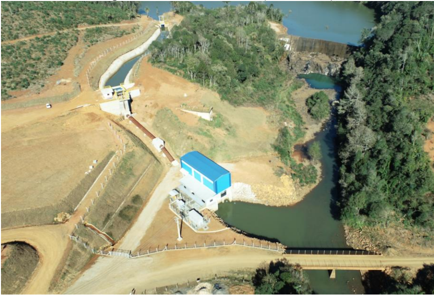
Figura 2 – Vista aérea da CGH (13/08/2024)
