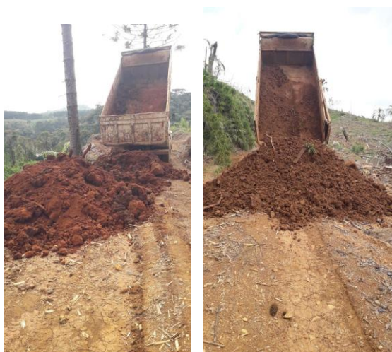
Figura 3. Exemplo de transposição de solo realizado na CGH São Bento.
