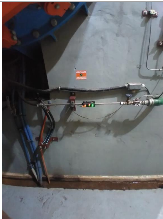
Figura 15: Linha/tubulação junto à parede com verificação visual e ausência de ponto crítico aparente.
