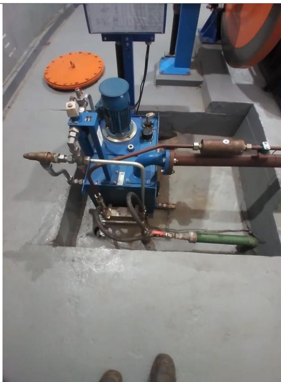
Figura 13: Casa de força: bomba, tubulações e bases de equipamento inspecionadas.
