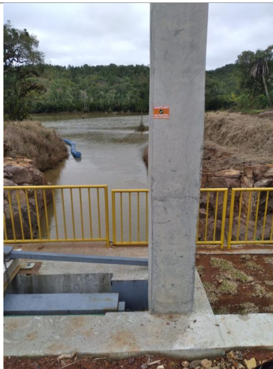
Figura 19: Estrutura hidráulica/barramento com identificação de área verificada.
