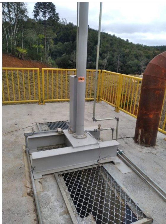
Figura 21: Estrutura superior da casa de força, grades e tubulações avaliadas.
