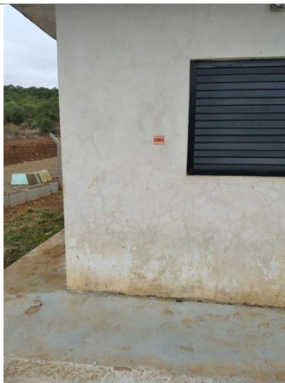
Figura 20: Edificação de apoio e parede externa avaliadas.
