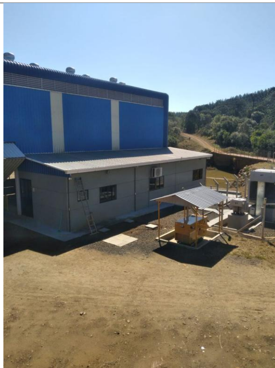
Figura 18: Visão geral da casa de força, gerador e transformador, com áreas externas monitoradas.
