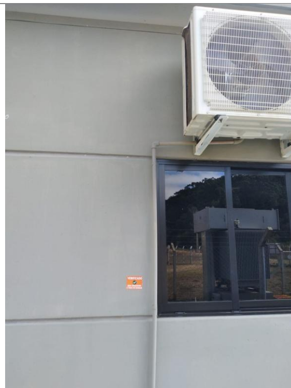
Figura 6: Área administrativa/parede externa com identificação “Verificado – Sem Criadouro e Foco de Dengue”.
