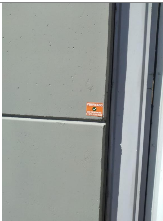
Figura 17: Fachada e área externa da edificação inspecionadas.
