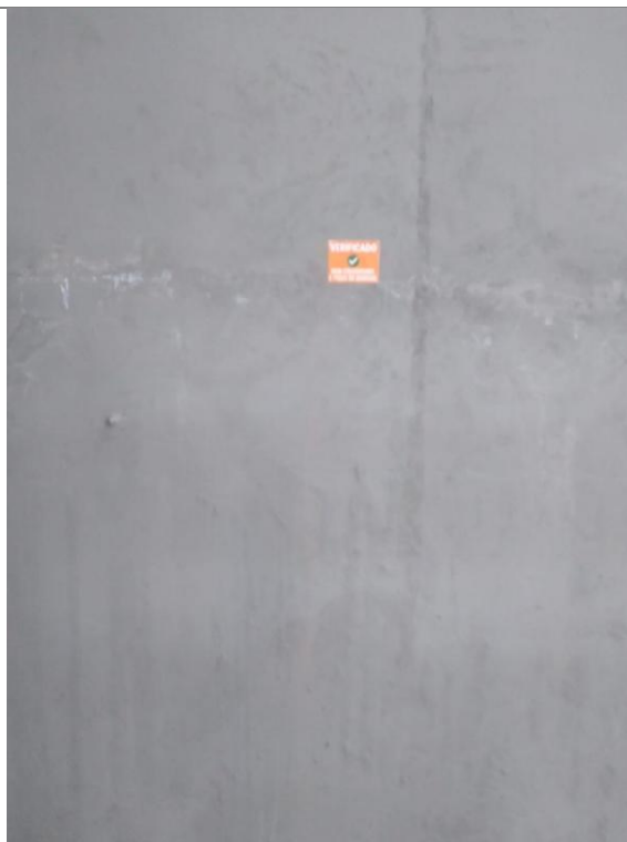
Figura 12: Parede interna/área operacional identificada como verificada.
