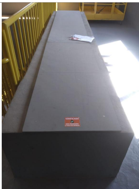
Figura 9: Superfície interna/bancada verificada, sem evidência de acúmulo de água.
