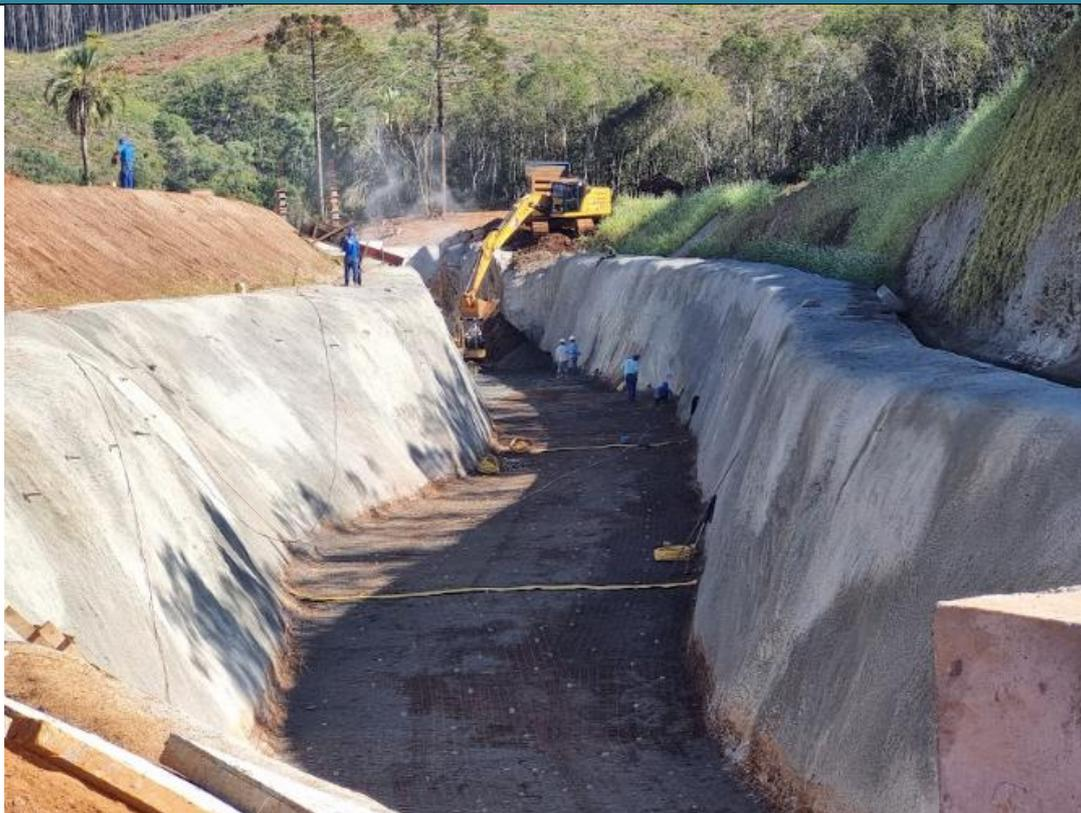
Estabilização do canal de adução e implantação de hidrosemeadura nas laterais do canal como forma de proteger de erosões.
