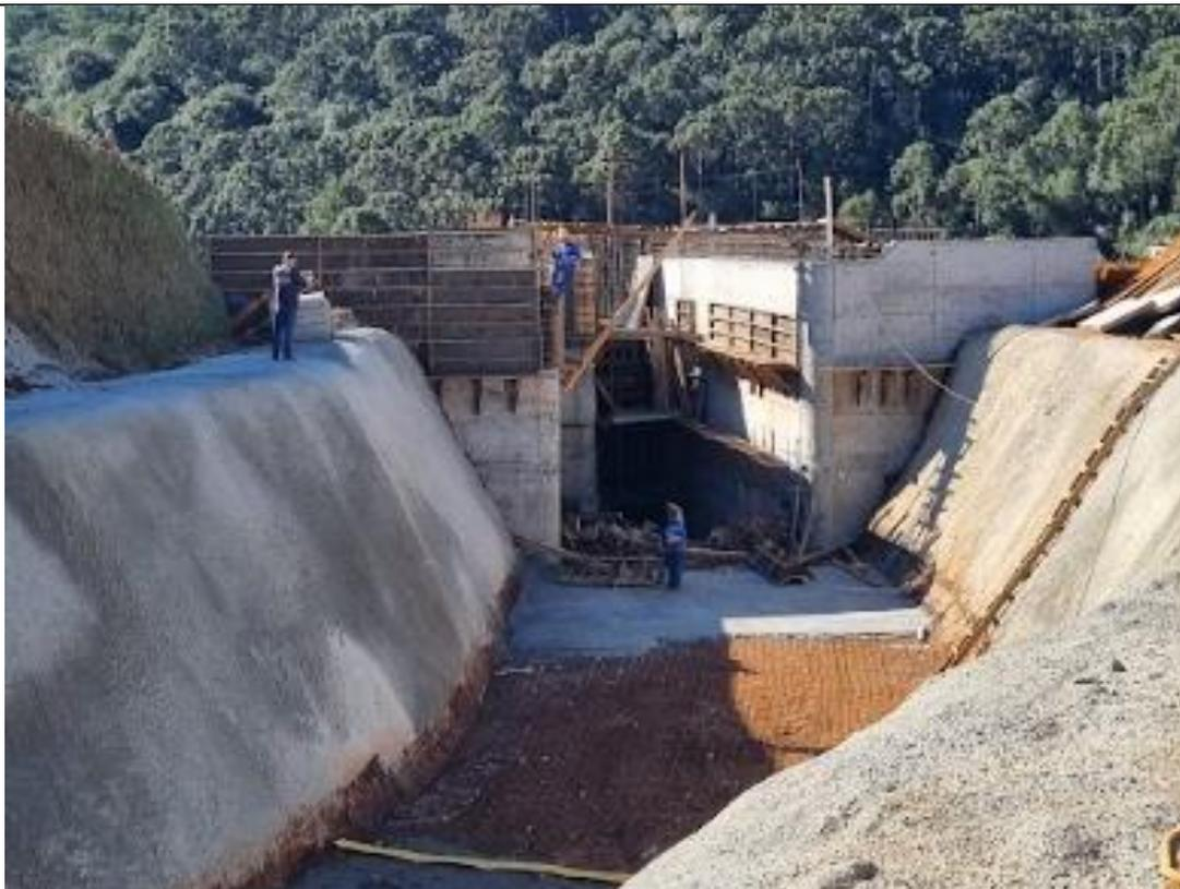
Final do canal de adução, início da construção da camera de carga.
