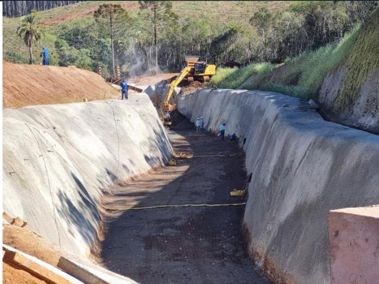
**CONSTRUÇÃO:** Estabilização do canal de adução e implantação de hidrosemeadura nas laterais do canal como forma de proteger de erosões.
