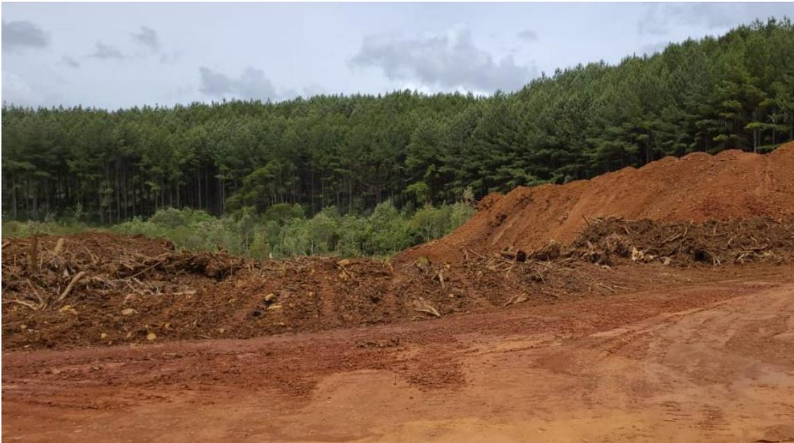
**Figura 24. Registro de horizonte orgânico removido da área de supressão de vegetação, separado para transposição nas áreas de recuperação.**
