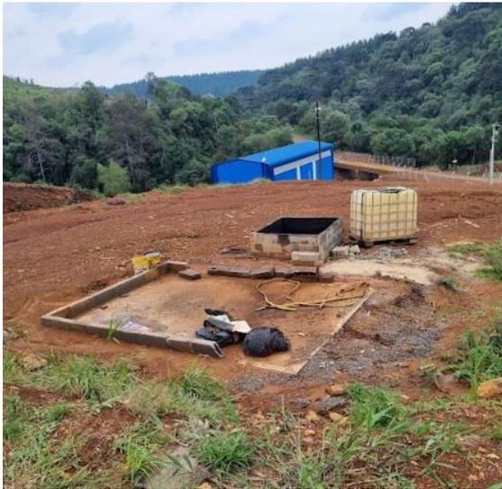
**Desmobilização** da área onde ficava locado o gerador e o IBC que armazenava combustível usado no gerador
