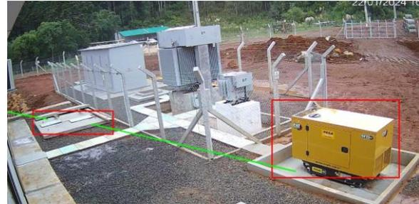
Gerador novo a diesel, backup de abastecimento de energia em caso de queda na geração e queda na rede da Copel.
