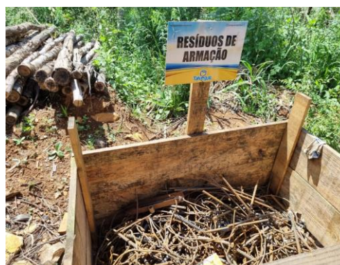
Armazenamento de sucata metálica – arames de armação
