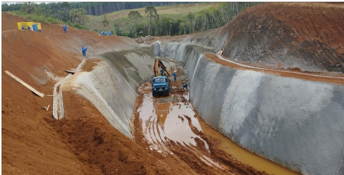
Estabilização do canal de adução
