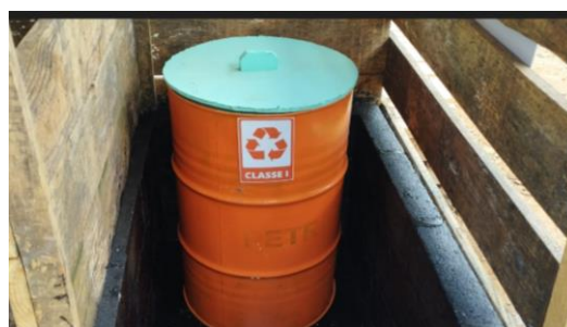
Tambor de 200 Litros para armazenamento de resíduos sólidos perigosos, identificado na cor laranja, com tampa em local coberto, bacia de contenção e piso impermeável
