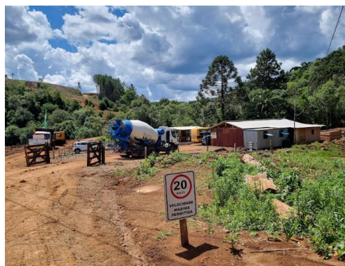
Velocidade máxima permitida no perímetro da obra de 20 km/h
