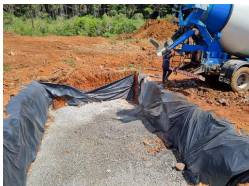
Medidas de controle ambiental na área de lavagem dos caminhões betoneiras
