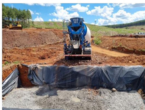
Medidas de controle ambiental na área de lavagem dos caminhões betoneiras
