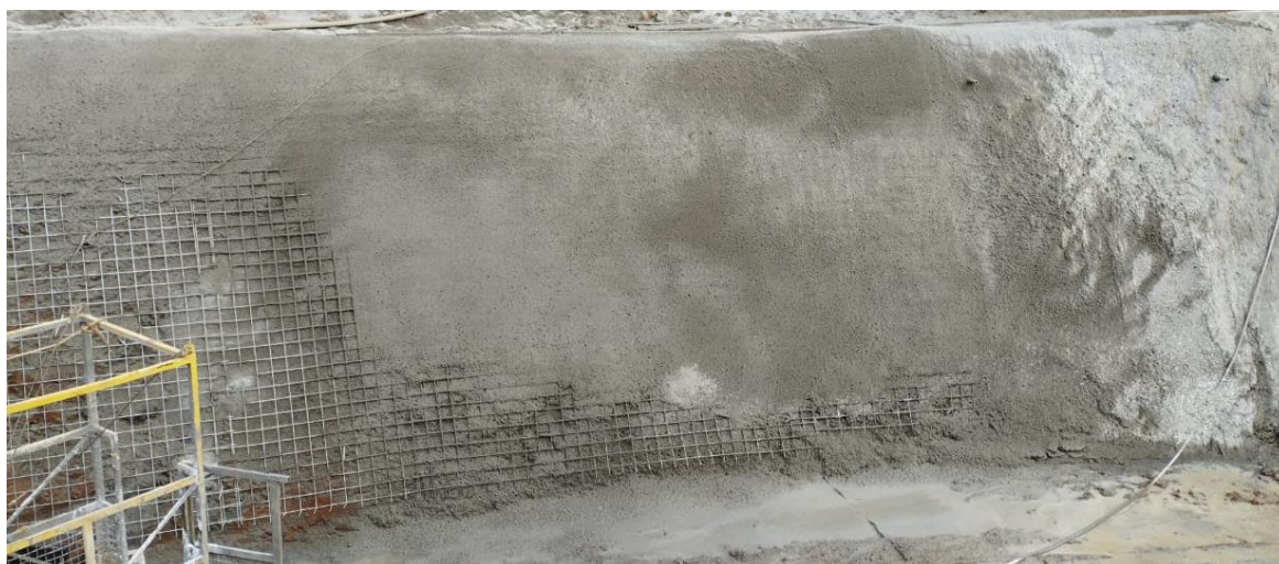
Estabilização do canal de adução
